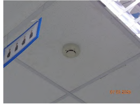
ภาพที่ 2.2-27 อุปกรณ์ตรวจจับควัน (Smoke Detector)
