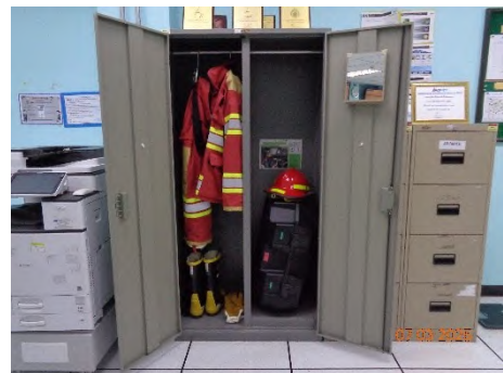
ภาพที่ 2.2-30 ชุดดับเพลิง/SCBA/ชุดป้องกันสารเคมี
