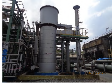
ภาพที่ 2.2-2 ปล่องระบายของหม้อต้มน้ำมัน (HTM)
