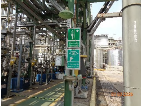
ภาพที่ 2.2-23 ฝักบัวฉุกเฉินสำหรับล้างตา
